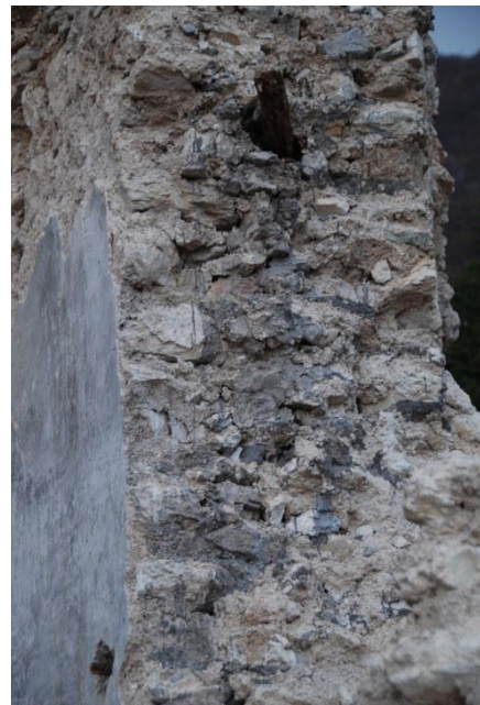
Figure 6-7 Sezioni murarie con fluidi cementizi iniettati. A sin., blocco del campanile di S. Maria la Bianca ad Ancarani (TE), a destra, sezione del muro della chiesa di S. Andrea, Campi, Norcia (PG).
