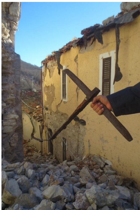
Figura 18 Capochiave metallico separato dal radiciamento ligneo tra le macerie del campanile di S. Stefano a Castelsantangelo sul Nera
