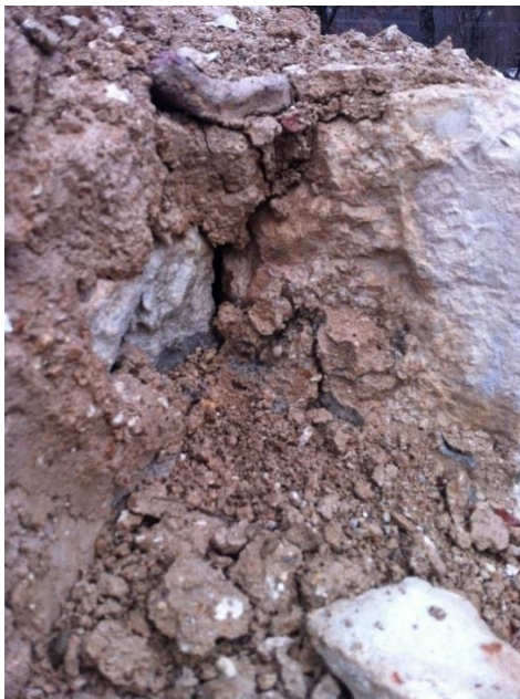
Figure 6-7 Sezioni murarie con fluidi cementizi iniettati. A sin., blocco del campanile di S. Maria la Bianca ad Ancarani (TE), a destra, sezione del muro della chiesa di S. Andrea, Campi, Norcia (PG).
