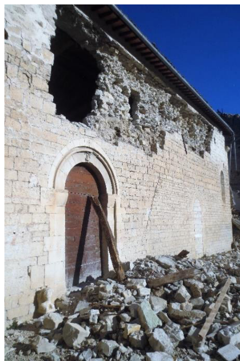
Figure 10-11 A sinistra, crollo parziale della muratura al di sotto di cordolo in calcestruzzo, con ancoraggi in verticale rimasti liberi. Visso (MC). A destra, Chiesa di S. Stefano a Castelsantangelo sul Nera (MC), caduta del paramento esterno nella zona sottostante il cordolo.
