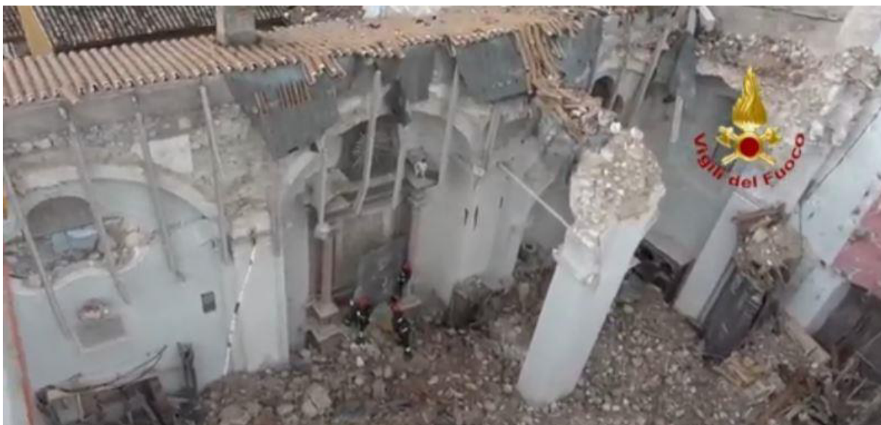
Figura 25 Chiesa di S. Maria Argentea a Norcia dopo il crollo della copertura (foto da drone dei VVFF).
