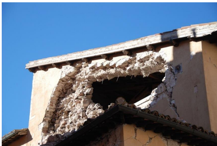
Figure 10-11 A sinistra, crollo parziale della muratura al di sotto di cordolo in calcestruzzo, con ancoraggi in verticale rimasti liberi. Visso (MC). A destra, Chiesa di S. Stefano a Castelsantangelo sul Nera (MC), caduta del paramento esterno nella zona sottostante il cordolo.
