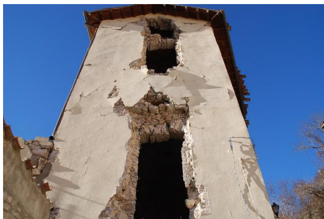
Figure 19-20 Palazzo Terenzi a Castelsantangelo sul Nera. Il fronte dopo la caduta dei contorni in pietra e gli elementi lapidei a terra.
