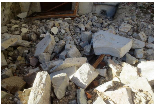
Figure 19-20 Palazzo Terenzi a Castelsantangelo sul Nera. Il fronte dopo la caduta dei contorni in pietra e gli elementi lapidei a terra.
