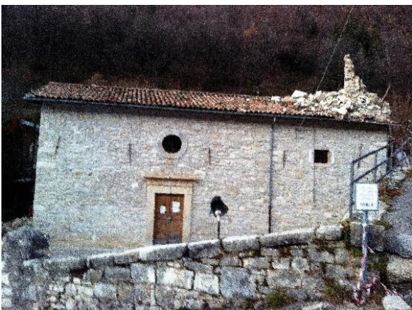
Figura 17 Chiesa di S. Pietro a Vallinfante (MC). La presenza dei tiranti sugli archi interni ha evitato il danneggiamento delle pareti laterali della navata.
