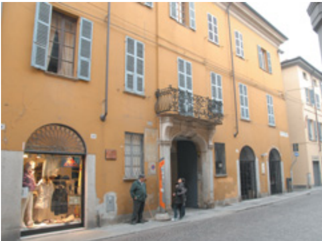
Fig. 4 - Piacenza, palazzo Mischi: il fronte su via Garibaldi prima dei lavori di restauro
