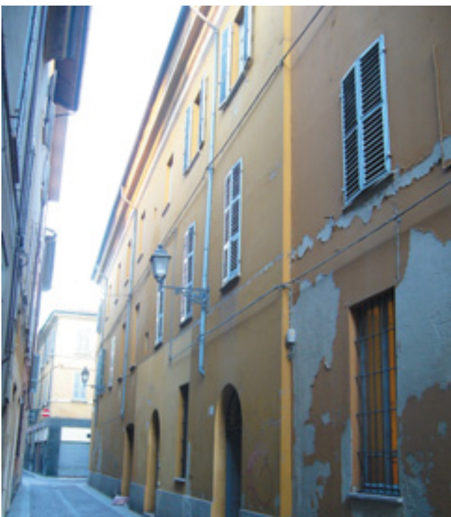
Fig. 8 - Piacenza, palazzo Mischi: il fronte su cantone dei Cavalli prima dei lavori di restauro
