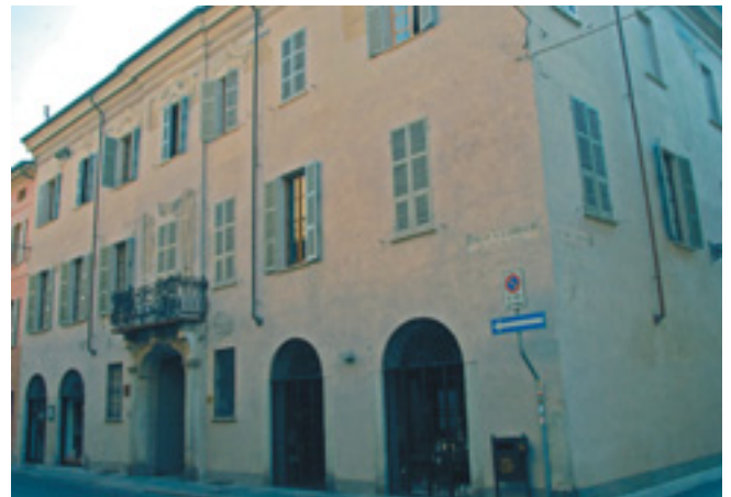
Fig. 7 - Piacenza, palazzo Mischi: il fronte su via Garibaldi dopo i lavori di restauro
