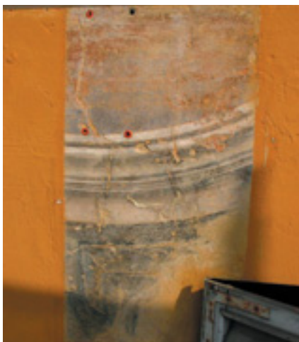
Fig. 1 - Campionatura della facciata
