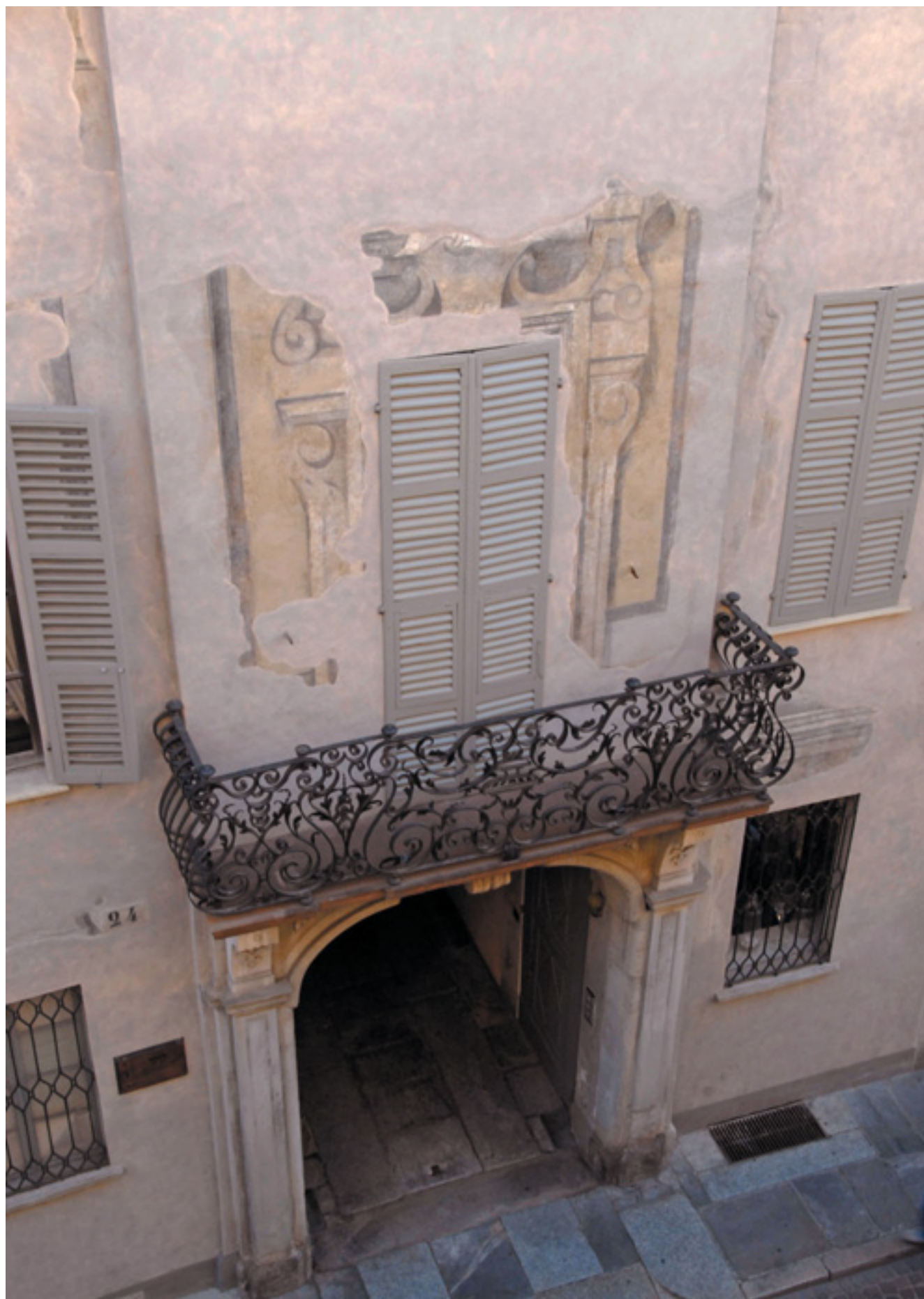
Piacenza, palazzo Mischi, il fronte dopo il restauro
