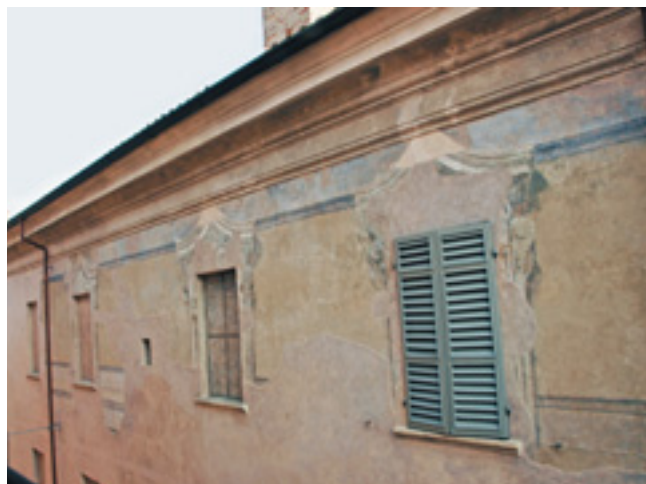
Fig. 13 - Piacenza, palazzo Mischi: particolare della facciata su cantone Cavalli
