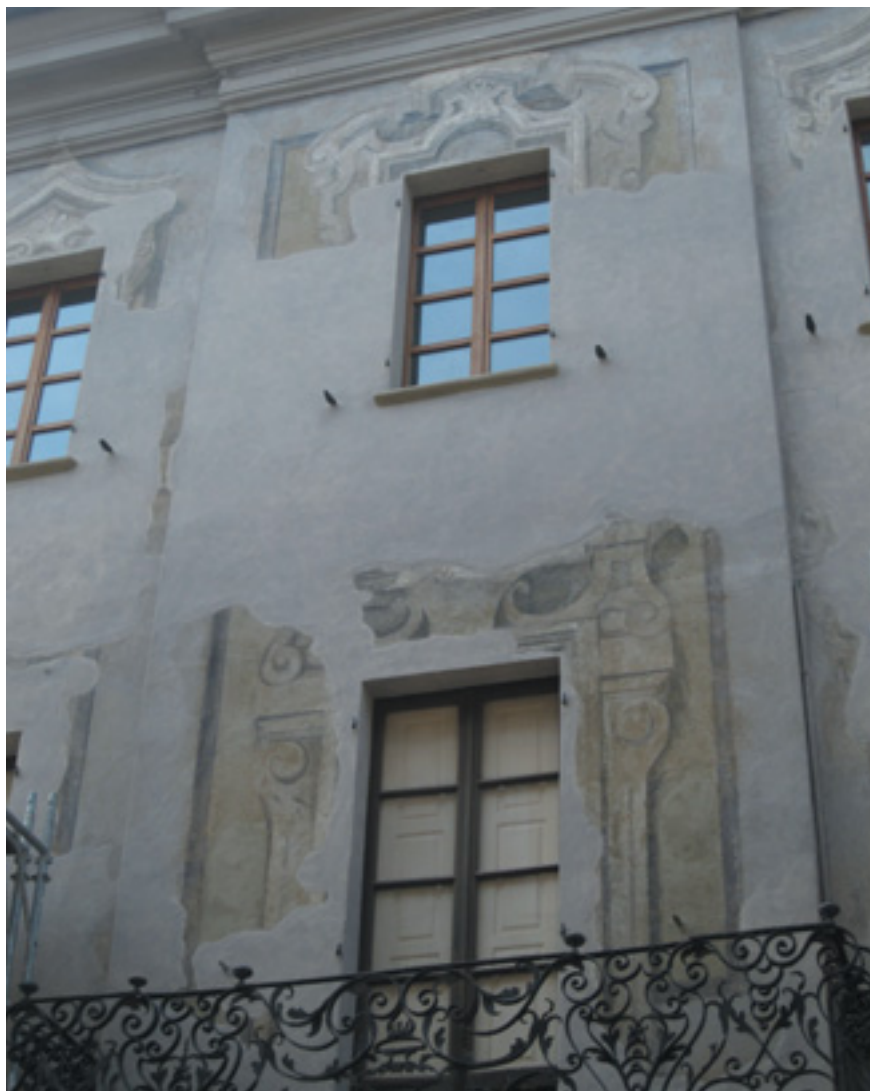
Fig. 1 - Piacenza, palazzo Mischi: porzione di muratura intonacata affrescata rinvenuta al di sotto della facciata settecentesca su via Garibaldi
