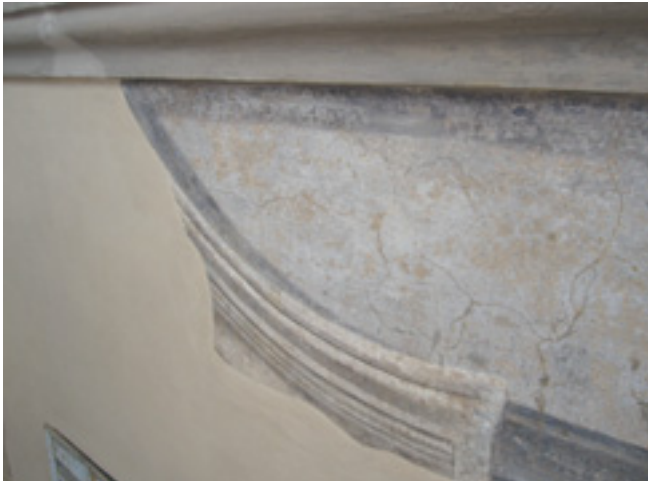
Fig. 10 - Piacenza, palazzo Mischi: particolare della facciata principale al termine delle operazioni di restauro delle parti decorate e di reintegrazione delle lacune degli intonaci prima del riequilibrio cromatico
