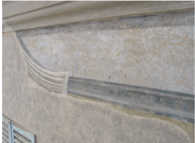
Fig. 11 - Piacenza, palazzo Mischi: particolare della facciata principale dopo il riequilibrio cromatico tramite esecuzione del neutro sulle parti di nuovo intonaco
