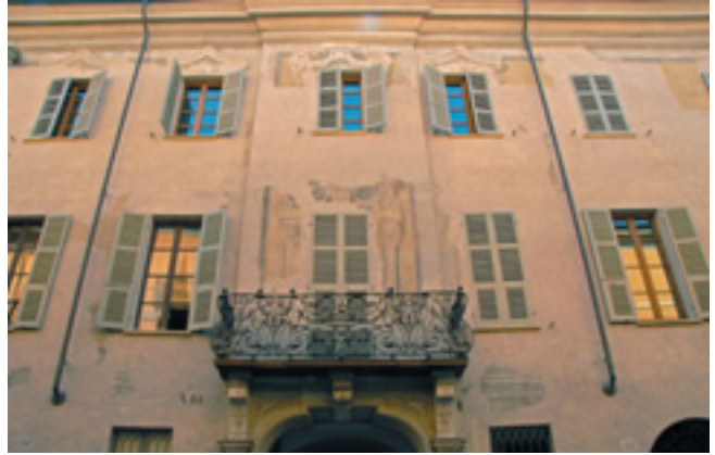
Fig. 7 - Palazzo Mischi, decorazione a quadratura, part. fronte su via Garibaldi
