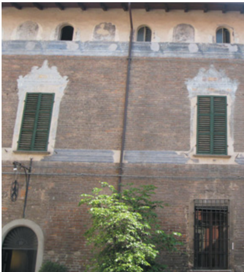
Fig. 11- Palazzo Scotti di Sarmato, prospetto su via al Teatro
