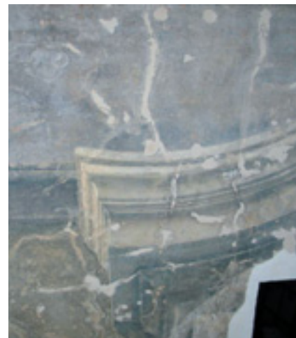
Fig. 3 - Rimosso il primo strato di tinte incongrue
