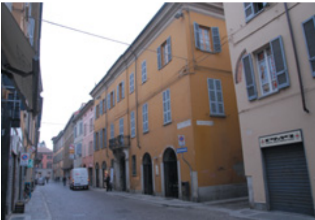
Fig. 6 - Piacenza, palazzo Mischi: il fronte su via Garibaldi prima dei lavori di restauro
