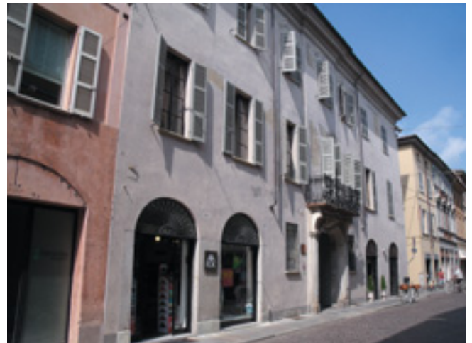
Fig. 5 - Piacenza, palazzo Mischi: il fronte su via Garibaldi dopo i lavori di restauro
