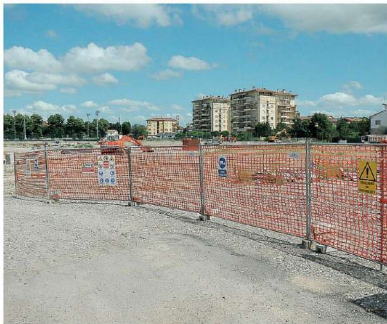
L'area dell'ex manifattura Tabacchi con i lavori in corso FOTO LUNINI
